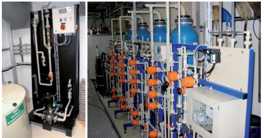
Bild 4: Ionenaustauscheranlage zur Kreislaufführung von Spülwässern mit externer (links) und interner Regeneration (rechts) der beladenen Harze.
