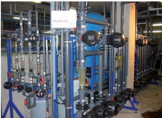
Neue Selektiv-Ionenaustauscheranlage
