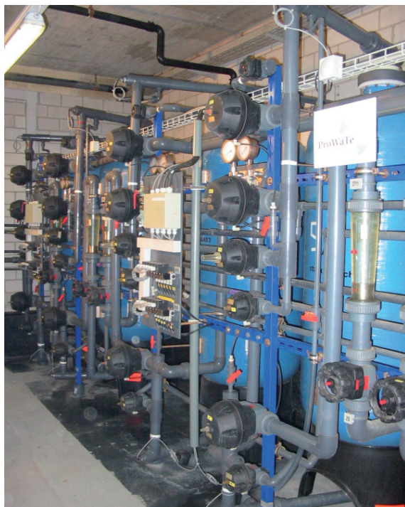
Neue Ionenaustauscher-Kreislaufanlage
