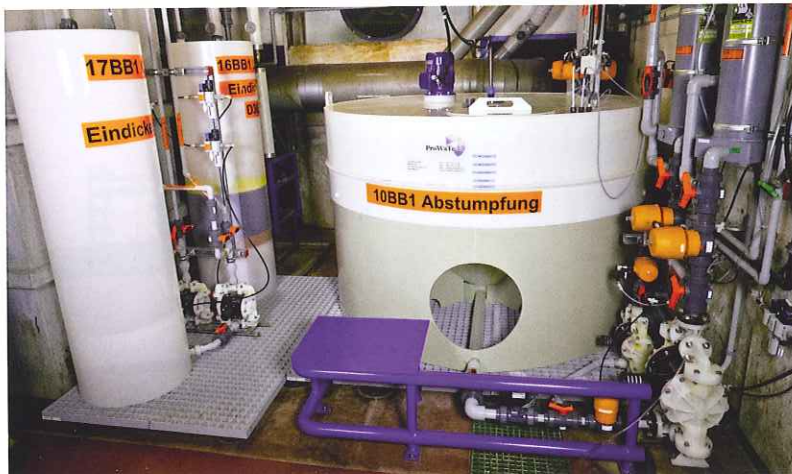
Abstumpfung und Verdünnung aus hochwertigem PVDF-Material
