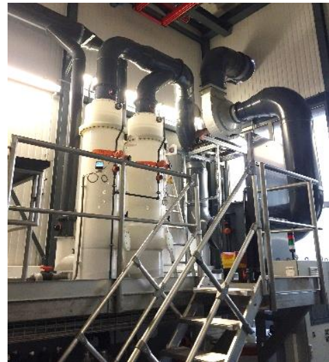
Abbildung 11: Abluftwäscher in PVDF mit 4'000 m³/h Leistung (Fa. ProWaTech AG)
