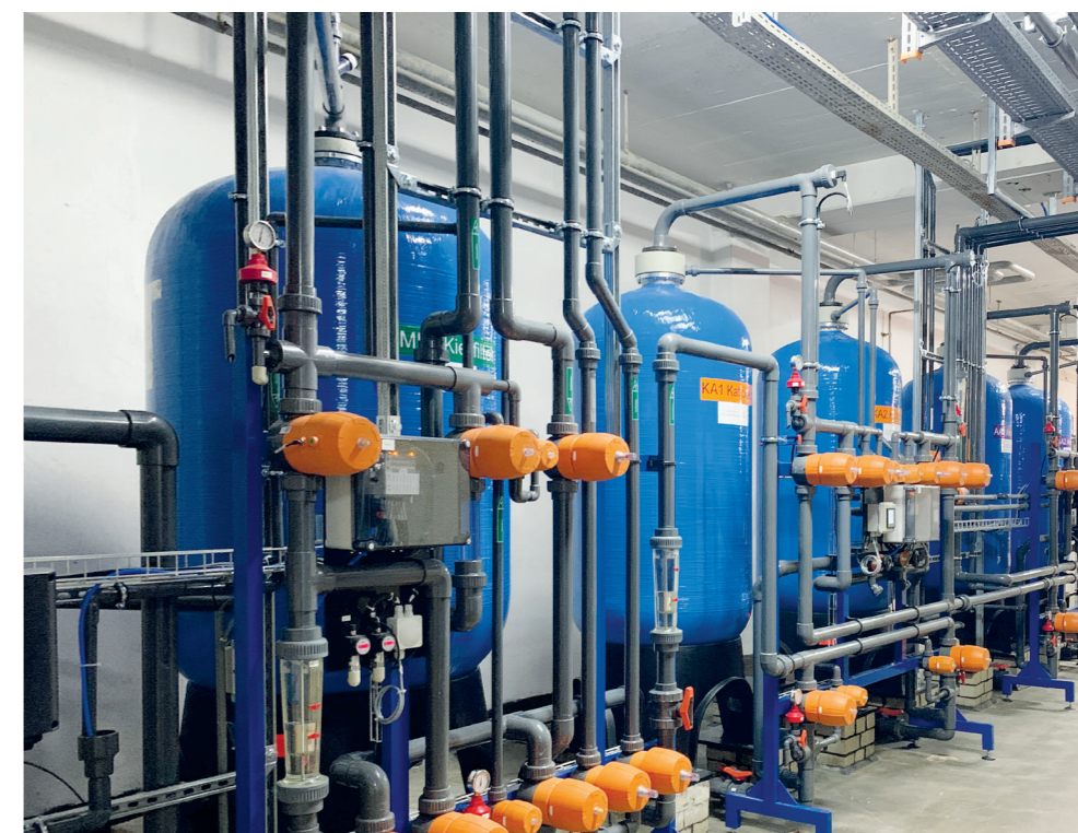
Neue Ionenaustauscher-Kreislaufanlage
