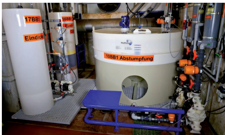
Bild 1: Abstumpfung und Verdünnung aus hochwertigem PVDF-Material
