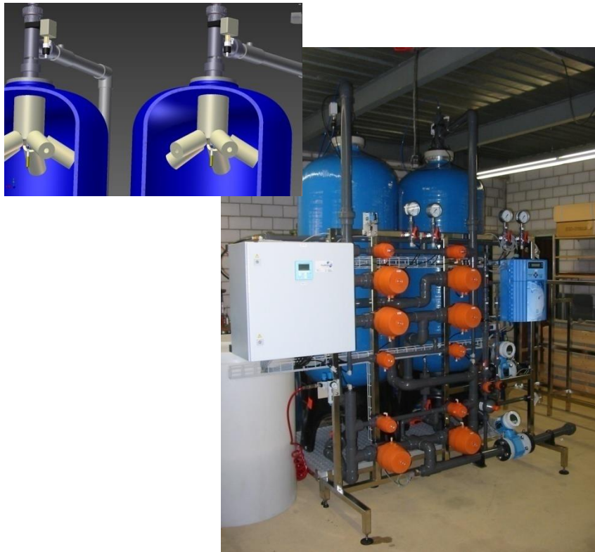
qualitätsgesteuerte Enthärtungsanlage in Reihenschaltung sowie Gegenstromregeneration
