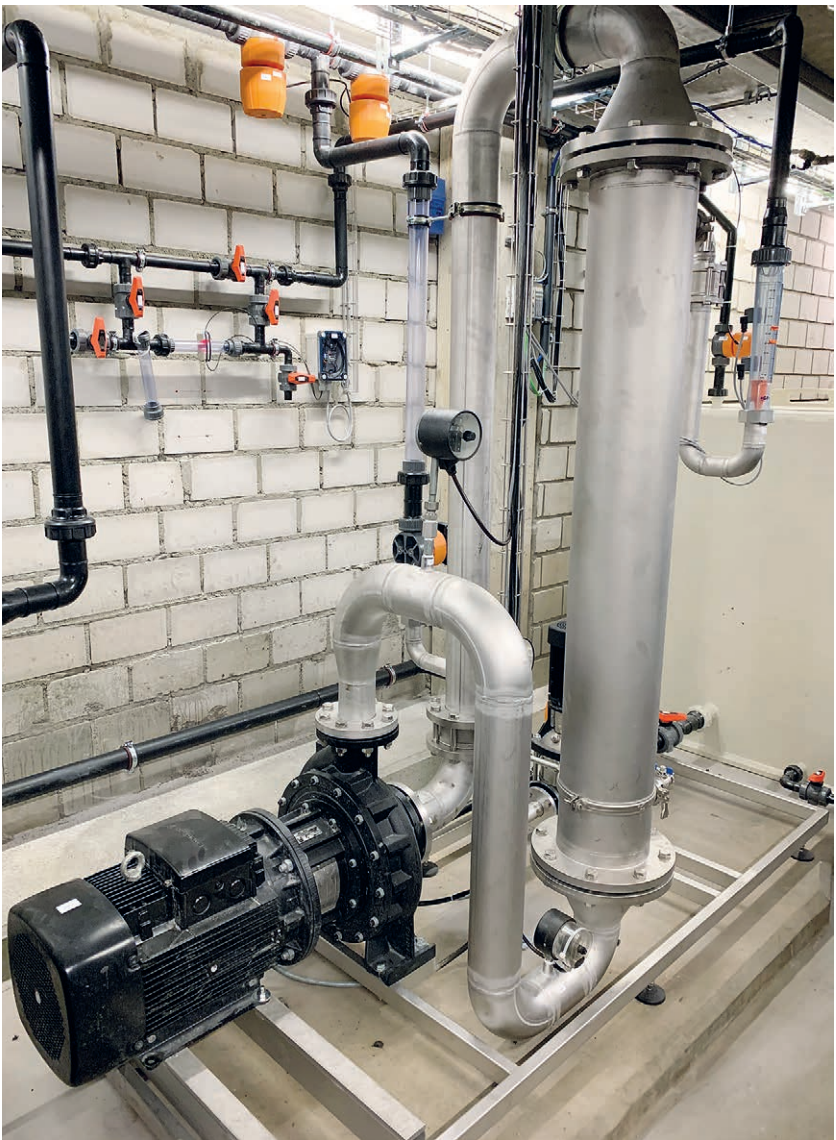
Die kompakte Konstruktion im 3D-Modell und der Einbau der Ultrafiltration.
