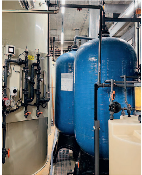
Abb. 8: Bild nach Versetzen des Kationenaustauschers
