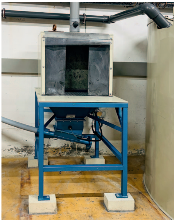
Abb. 9: Pulverdosieranlage für Flockungsmittel
