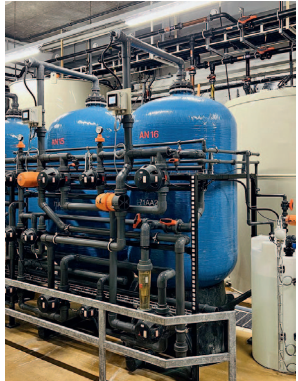
Abb. 4: Umbau zu Reihenwechselschaltung, orange Ventile
