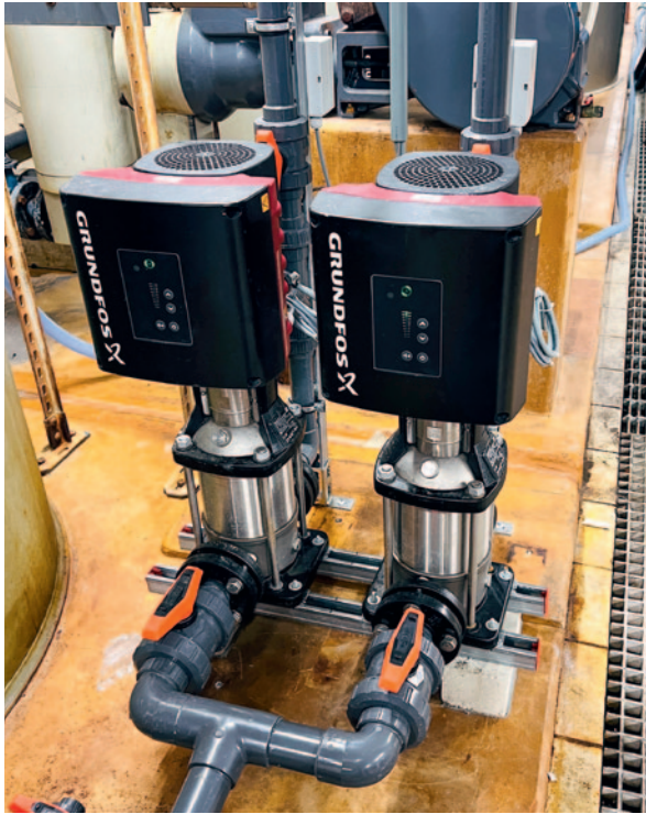
Abb. 7: Frequenzgeregelte Rohwasserpumpen
