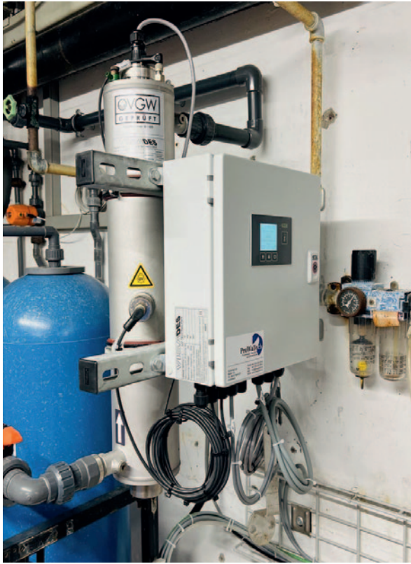
Abb. 5: UV-Entkeimung mit Durchflussarmatur
