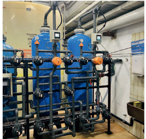
Abb. 6a links: Anionen-Etagenaustauscher vor dem Ersatz
